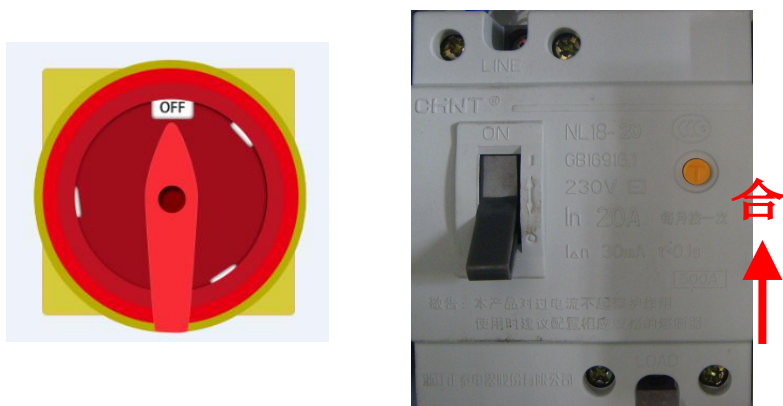
图 4-1 总电源开关及漏电开关
